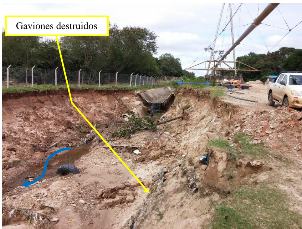
Foto N° 2 Situación actual del canal de drenaje pluvial municipal destruido
