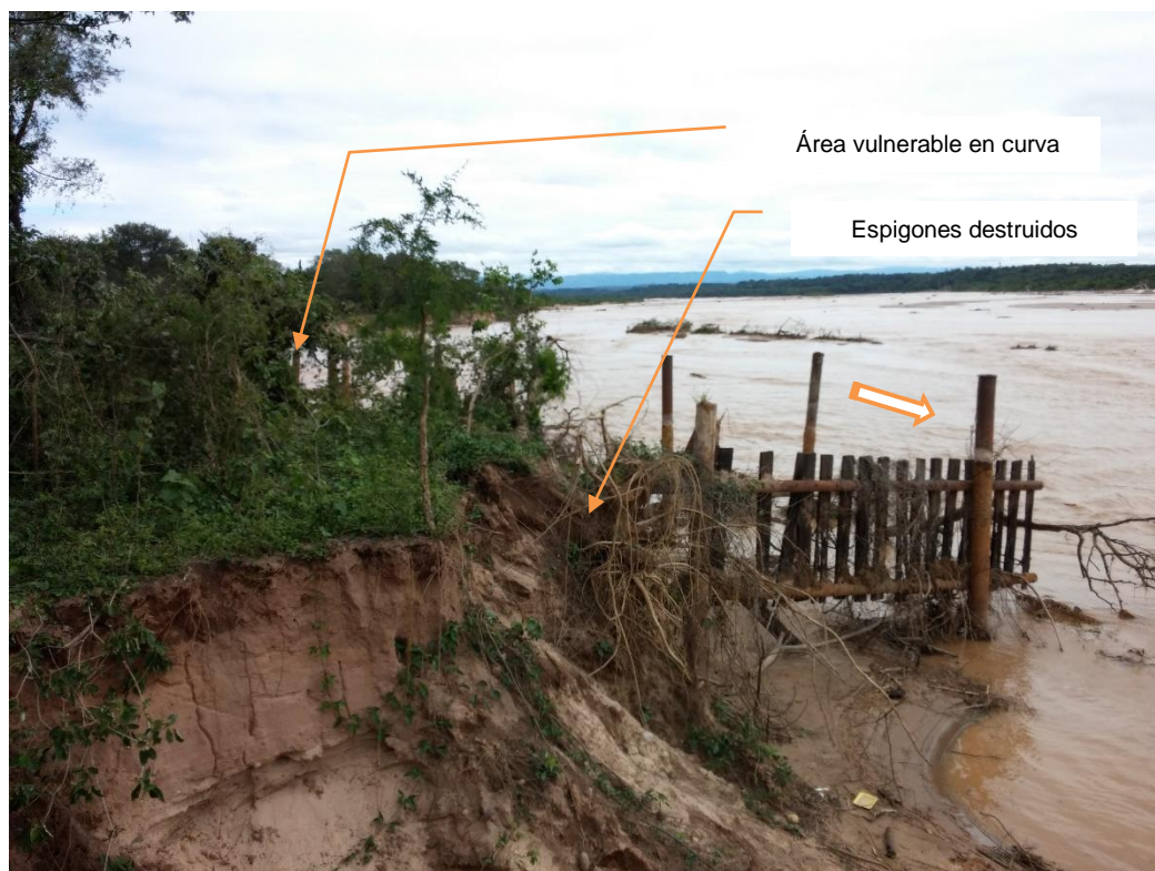
Foto N° 4 Espigones tipo peine totalmente deteriorados
